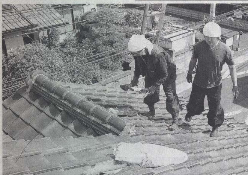
軽量瓦に交換し、柱の負担を減らす改修工事(さいたま市内で)
