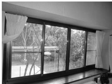
断熱窓に交換
