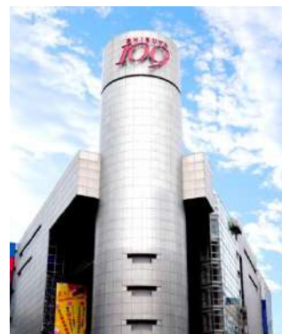
道玄坂共同ビル
