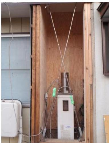
「コボット」とは、オールステンレスの耐震補強金物。今まで耐力壁として見る事ができなかった窓などの開口部にも取付が可能となった画期的な金物です。また、従来の木造筋かいと比較すると、地震時の筋かい本体の破損や抜けを軽減しています。 鳥海和也
