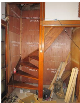
住みながらの工事ですので階段を残しての壁補強。 さすが！大工さん
