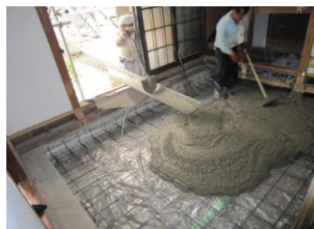
道路から長いシュートを使ってのコンクリート打ち
