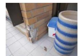
写真下：外壁タイルの落下 (緑区)
