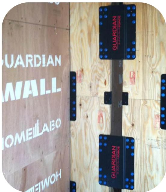
懸命頑張ることができそうです。制振とは、地震エネルギーを熱に変換して揺れを吸収する技術です。家具の転倒や移動の被害が極めてすくなくります。東京スカイツリーでも制震構造が取り入れられています。
