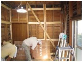
壁を一度解体して新しく耐震壁を入れました。柱と柱の間に筋かいを入れ、また、強度の強い金物を使用する事により大きな地震にも耐えることができます。
