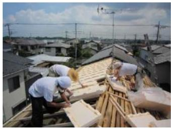
耐震強度を上げるため、屋根を瓦からコロニアルに葺き替えるにあたり、瓦を降ろし断熱材を敷きました。これによって、建物が軽くなり耐震性能が上がり、家の中の温度を快適にするこができました。
